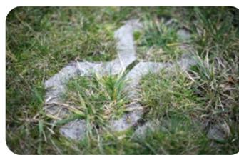
Durch Rasengittersteine versickert mehr als durch Asphalt. Weniger Hochwasser, mehr Wasser für Pflanzen und angenehmeres Kleinklima.
